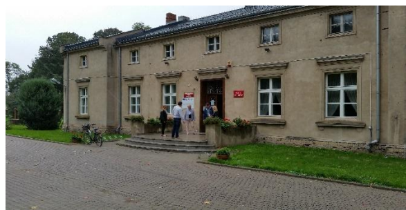
Fot.4 Wymagający remontu zabytkowy pałac, w którym mieści się Biblioteka Gminna.
