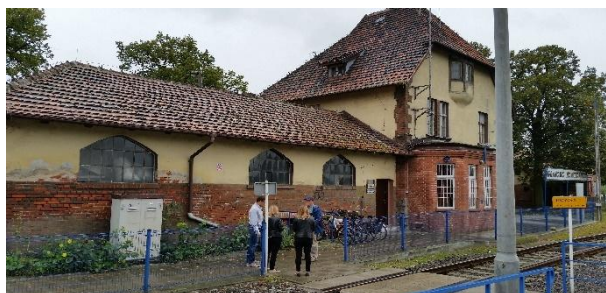
Fot.1 Wymagający remontu oraz nadania mu nowych funkcji budynek dworca kolejowego.
