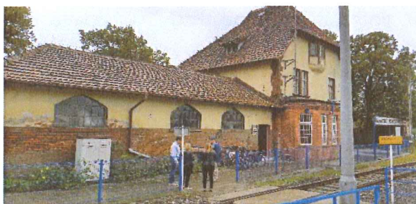
Fot.1 Wymagający remontu oraz nadania mu nowych funkcji budynek dworca kolejowego.
